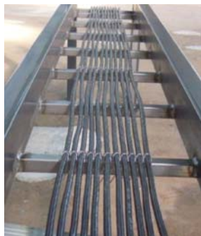
(シート施工前)
