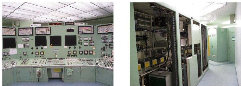
図3 原子炉制御盤（換気口無し）
