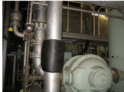
32 外部事象防護対象施設はない
