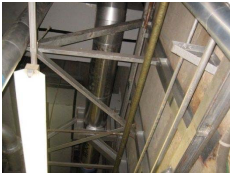
31 外部事象防護対象施設はない
