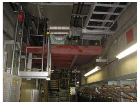
34 外部事象防護対象施設はない
