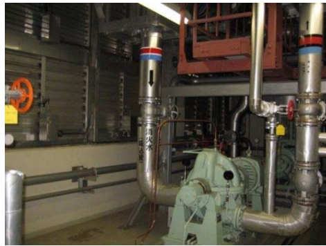
30 外部事象防護対象施設はない
