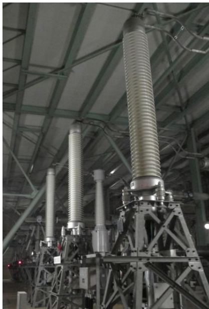
図 1-23 ブッシングの外観及び内部構造部のイメージ図
