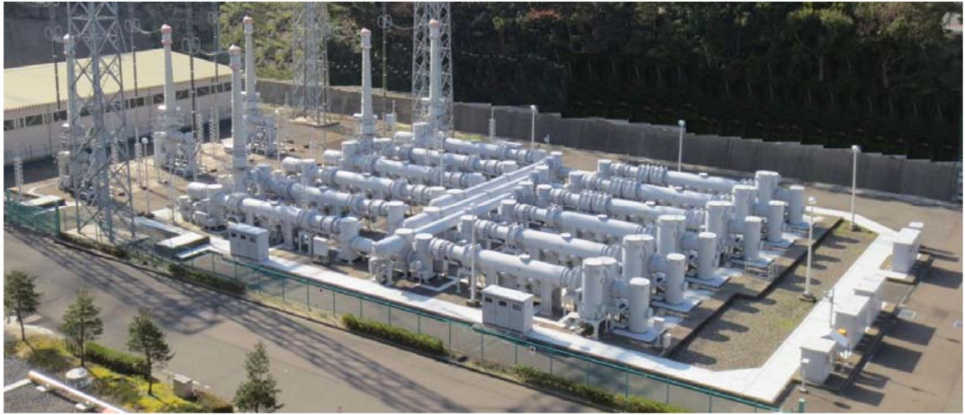
(ガス絶縁開閉装置イメージ図)
