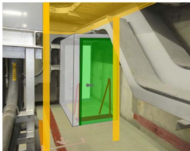
第14-2図 ケーブル処理室内階段室の設置イメージ
