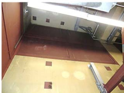
室内よりの状況 (3階 3F2)
