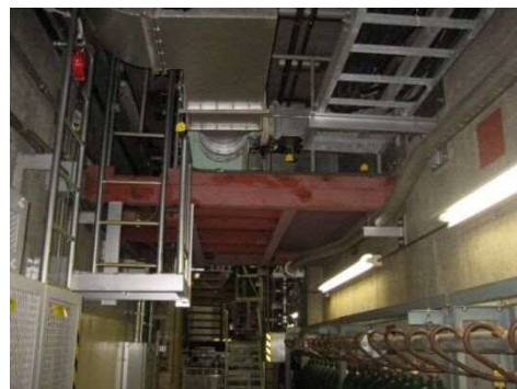
34 外部事象防護対象施設はない
