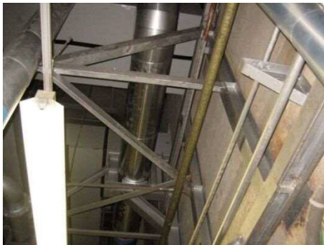
31 外部事象防護対象施設はない
