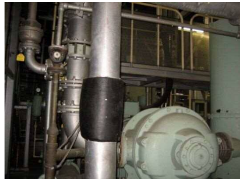
32 外部事象防護対象施設はない
