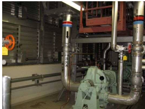
30 外部事象防護対象施設はない
