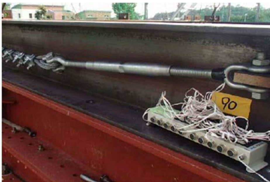
図 2-1 ひずみゲージ付きターンバックルの設置状況
