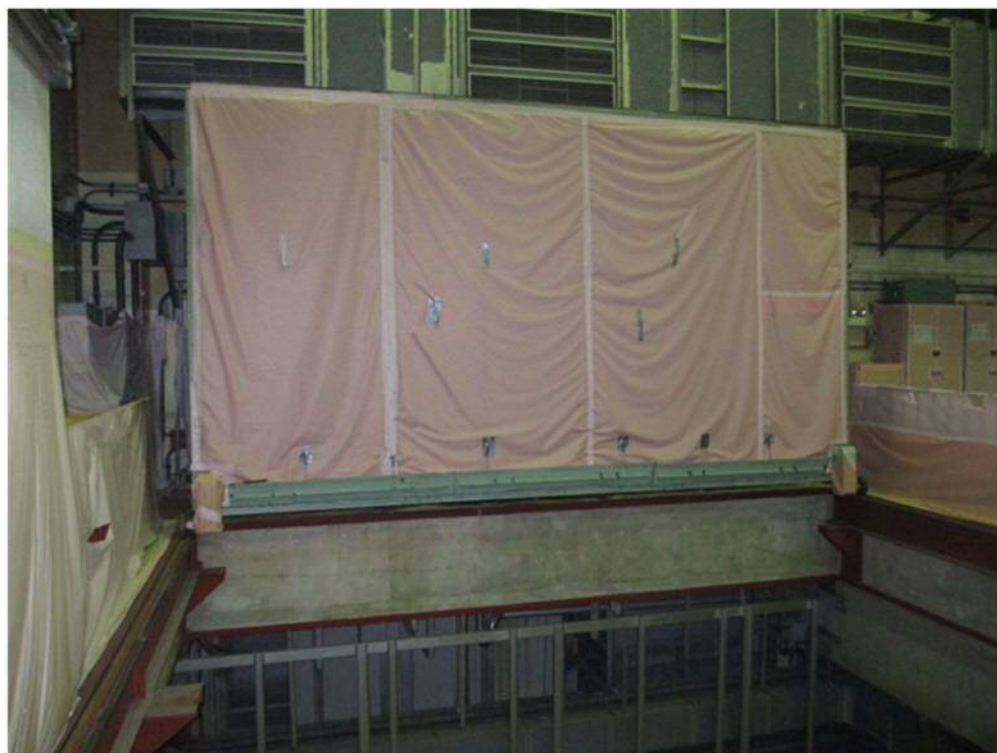
図 1-1 大物搬入口ハッチ (開状態)
